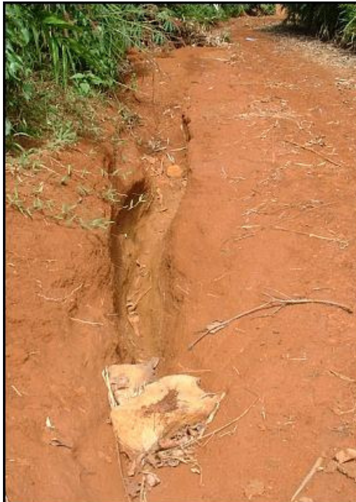
Hình 3.2. Đất dốc bị xói mòn
