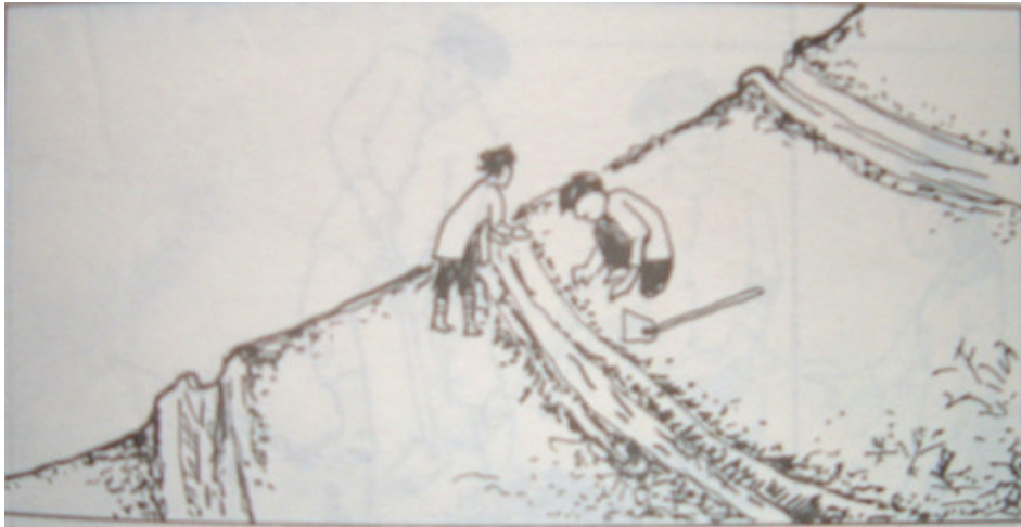
Hình 1-35. Đào rãnh là một biện pháp chống xói mòn
