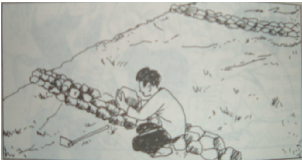
Hình 1-34. Xếp tường đá để giảm xói mòn
