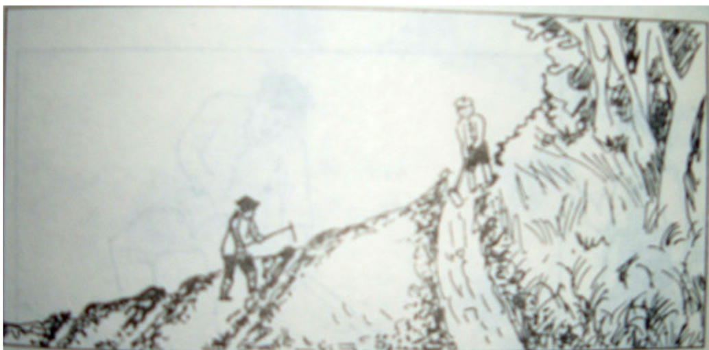
Hình 1-36. Rãnh đất được đào theo đường đồng mức
