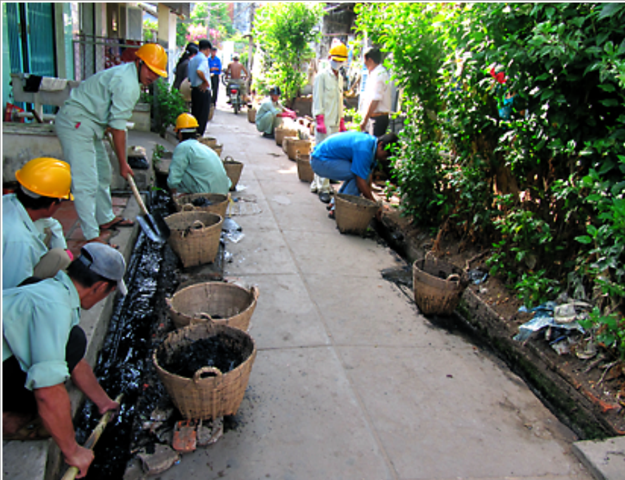
Nạo vét Hệ thống cống cấp ba (chiến dịch dọn vệ sinh), Trà Vinh, 02.06.2010
