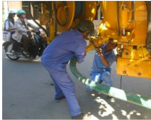
Thực tập hút bùn trong cống bằng xe hút ở Cần Thơ
