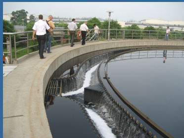
Thăm nhà máy xử lý nước thải tập trung
