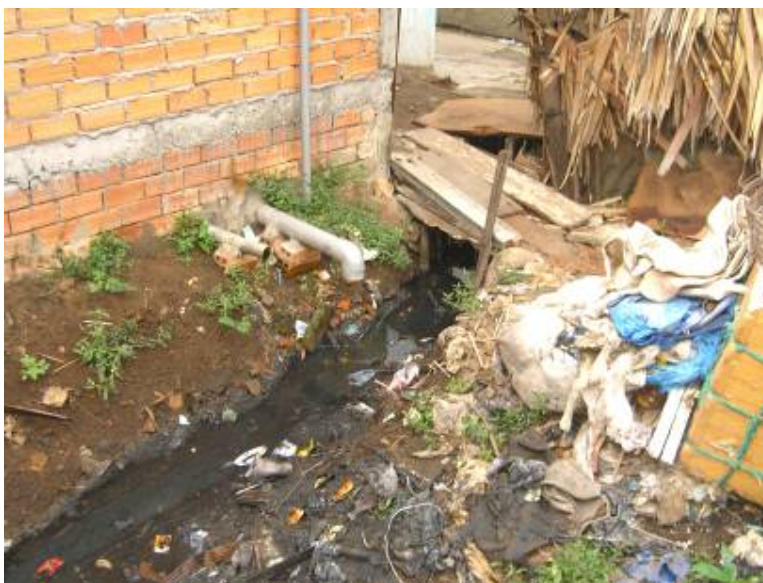
Ảnh 6: Mương thoát nước thải hộ gia đình – Phường 3
