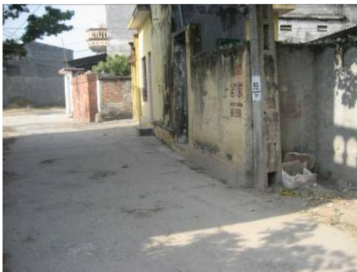
Ảnh 9: Cổng thoát nước cấp 3 - Phường Vũ Ninh
