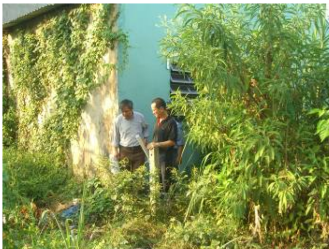
Ảnh 12: HGD thoát nước thải ra mương tự nhiên – Phường An Hòa
