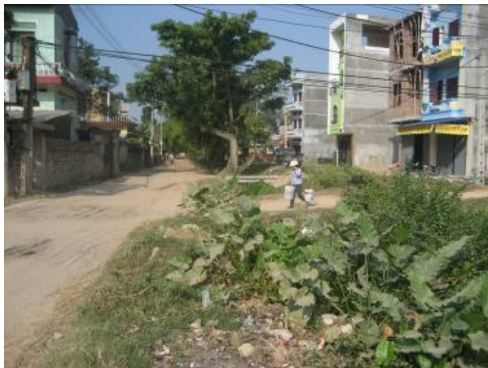
Ảnh 7: Mương TN công cộng dọc đường Đẩu Mã – Phường Vũ Ninh
