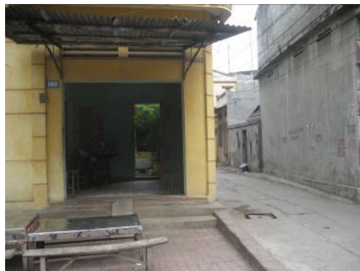
Ảnh 2: Cổng thoát nước cấp 3 – Phường Vệ An
