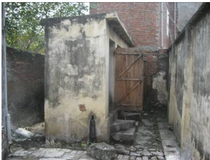
Ảnh 6: Nhà vệ sinh công cộng – Phường Tiên An
