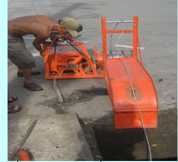
Lắp đặt cụm tời cạn hố ga
