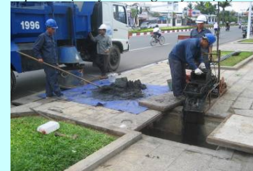
Kéo bùn cạn khỏi cống
