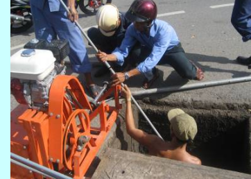
Luồn ống PVC kéo dây qua cống
