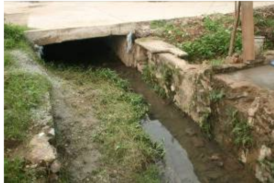
Nước thải từ nhà máy bia chảy trực tiếp vào hệ thống chung
